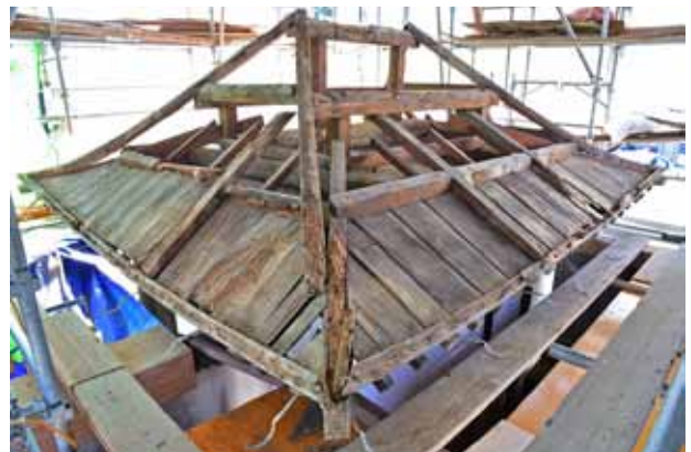
建立当初の状況が残る小屋組
