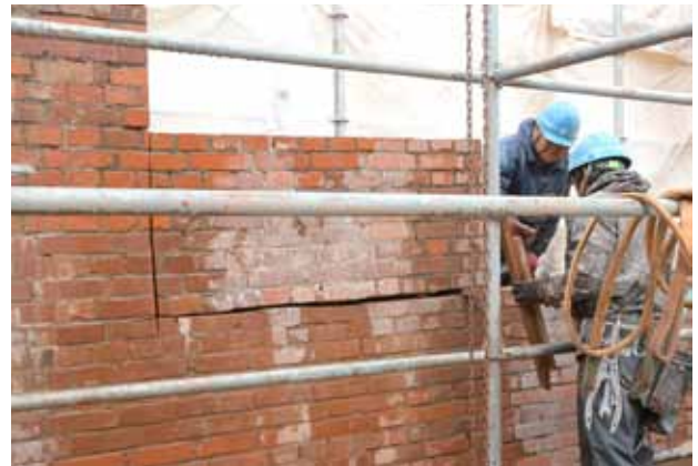
煉瓦塀の解体状況
