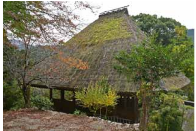
修理前の屋根（背面側：北面）
