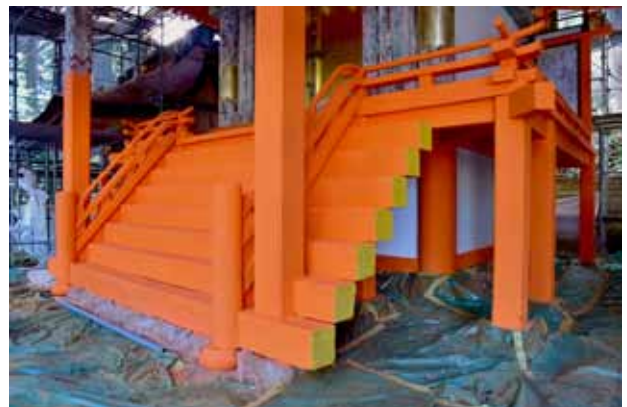
塗装工事の進捗状況（高野明神社）
