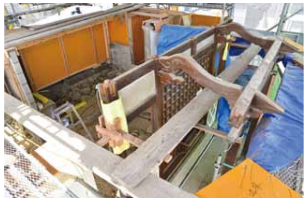
正面と向拝軸部を残した分解完了状況
