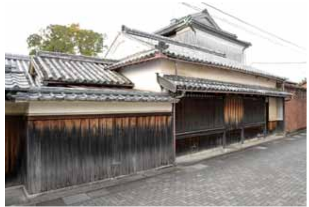
修理前の外観（手前・主屋、奥・御風楼）
