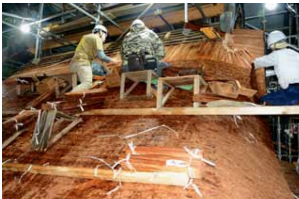
檜皮葺施工状況（高野明神社）
