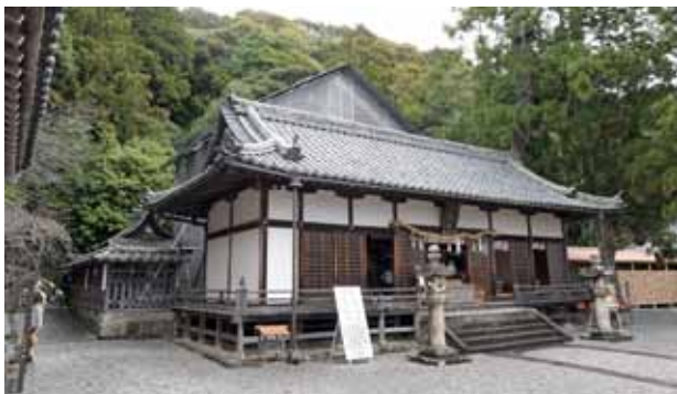
仮設工事の様子（瑞垣内に本殿を包み込む素屋根を建設）
