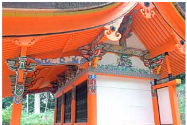
塗装工事後の本殿（南西から見上げる）
