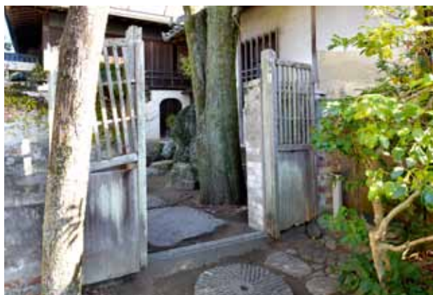
庭園内木製門扉 解体前の状況
