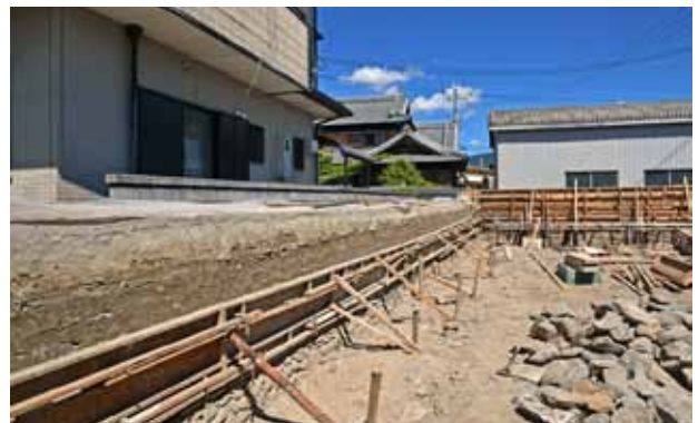
外周土塀の積み上げ状況（北西隅をみる）
