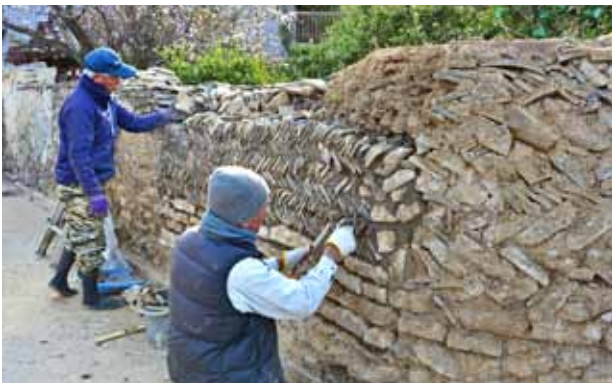
土塀破損部分の積み直し状況
