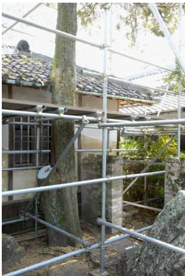
素屋根建地の組立・樹木の剪定状況
