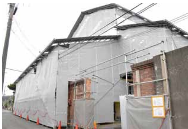
素屋根の建設状況（東面より見る）
