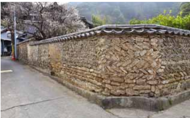
土塀修理完了状況（北面）
