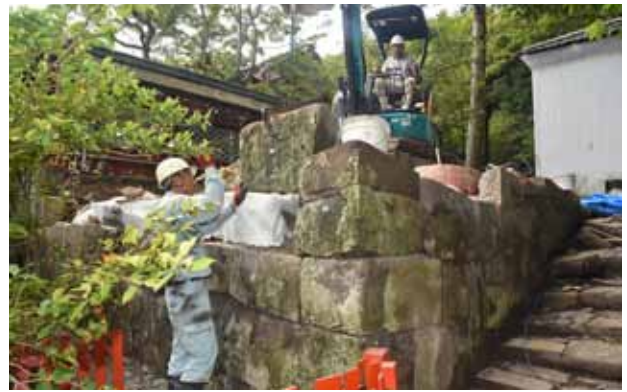
裏面を養生しながらの積み直し状況
