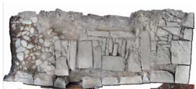
石垣1段目解体後上面（オルソ画像）
