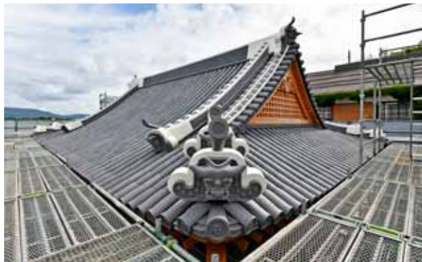
本瓦葺き屋根と漆喰工事の完成
