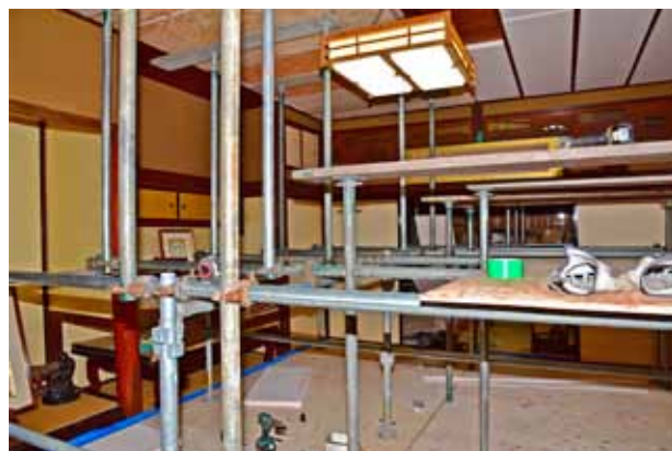
竿縁天井を養生しながらの住居での施工
