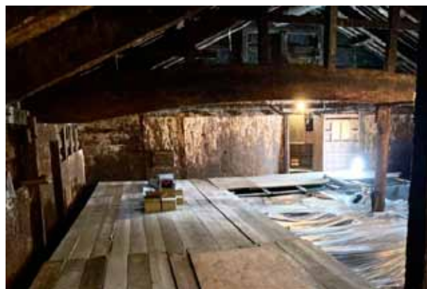
仕込み蔵の醸造樽の養生と仮設足場
