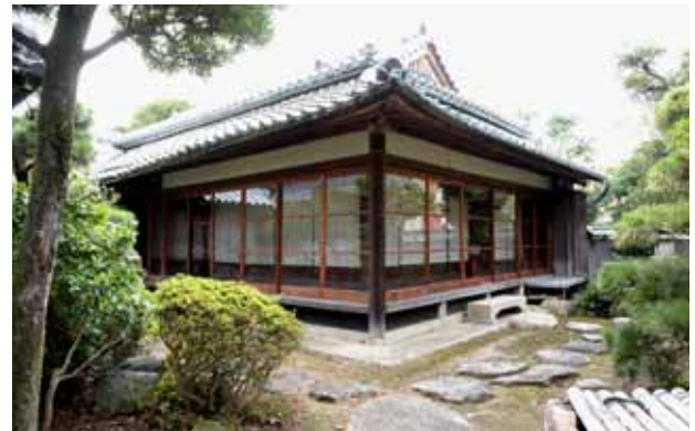
修理前の外観（本座敷）
