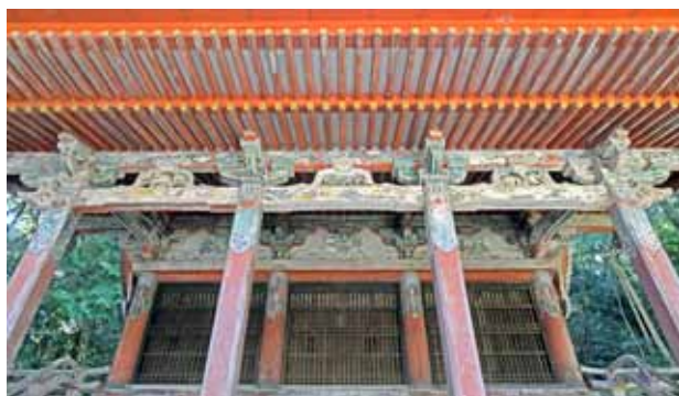
修理工事前の本殿（令和6年夏）
