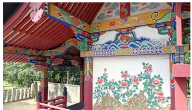
塗装修理（単色の塗り替え、彩色の補筆）の完了（力侍神社）
