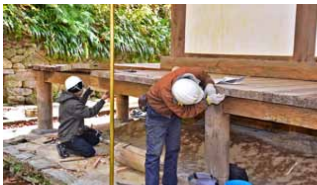
破損した背面縁廻り木部の補修状況
