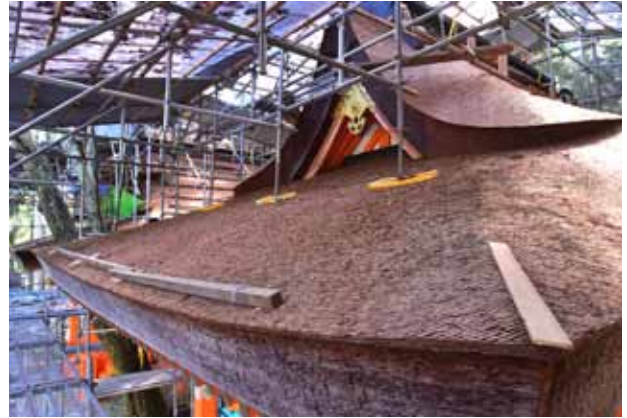
檜皮葺屋根の施工完了（丹生明神社）
