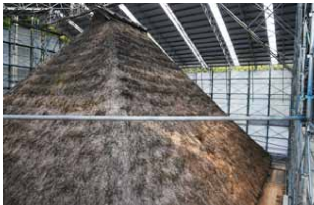
素屋根内部の状況（屋根正側面をみる）
