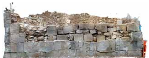
石垣3段目解体後正面（オルソ画像）
