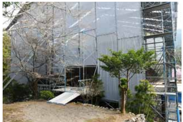
素屋根組立の完了状況（背面側：北面）
