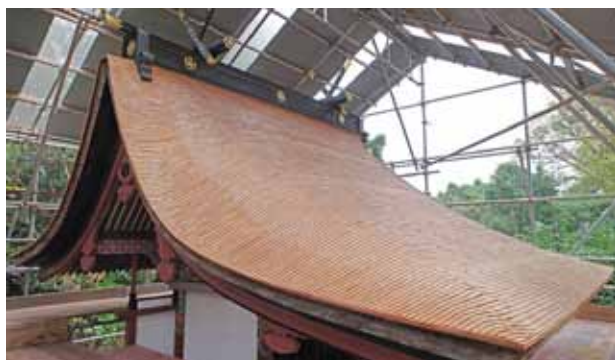
柿葺き屋根の葺き替え工事完了（八王子神社）
