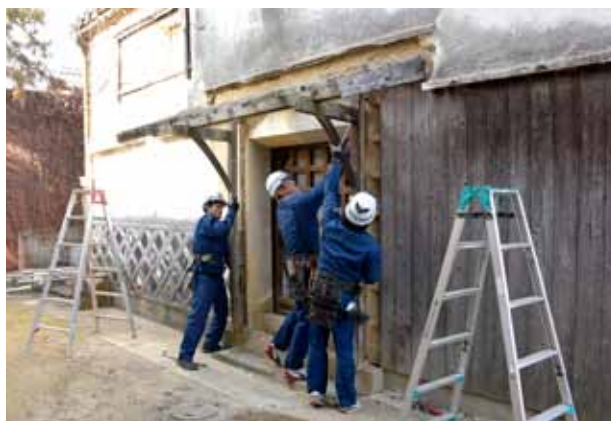
新蔵南面庇の解体状況
