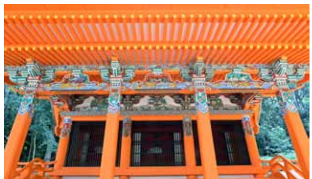
修理工事後の本殿（令和7年秋）
