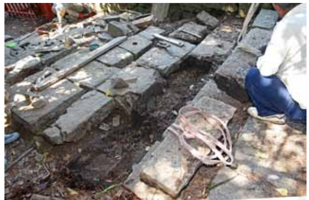
石階段の据え直し状況
