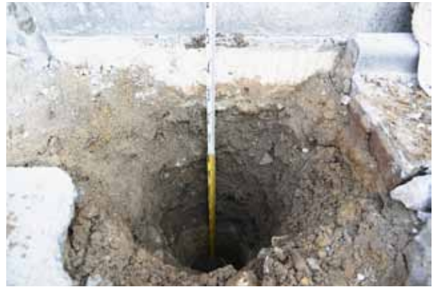
上中野馬上遺跡工事立会調査 掘削状況（南から）
