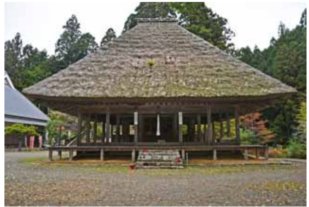
修理前の全景（正面側：南面）
