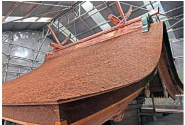
屋根工事後・塗装工事前の本殿（南西から見る）
