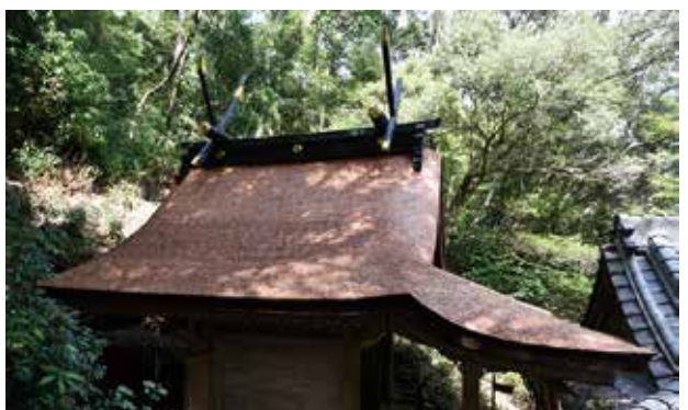
写真7 屋根葺き完了・素屋根解体状況
