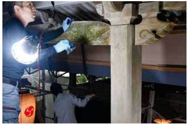
写真6 藻類清掃の作業状況
