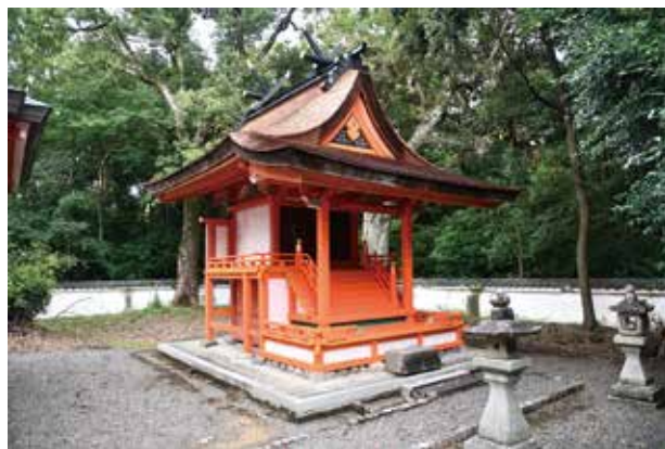
写真1 旧竹房神社本殿の竣工状況
