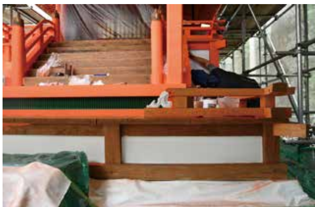
写真2 塗装塗替の作業状況
