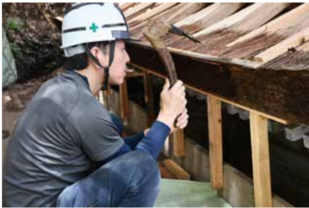
写真4 檜皮軒付積替の作業状況
