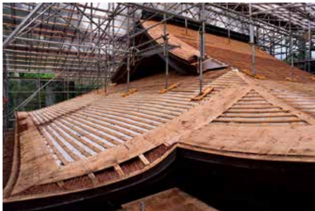
旧檜皮屋根解体の状況
