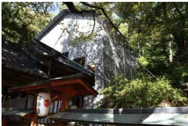
写真2 素屋根の組立状況
