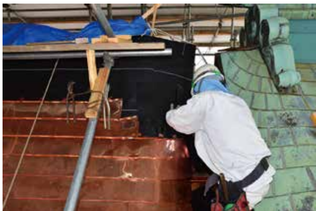
銅板葺きの施工状況
