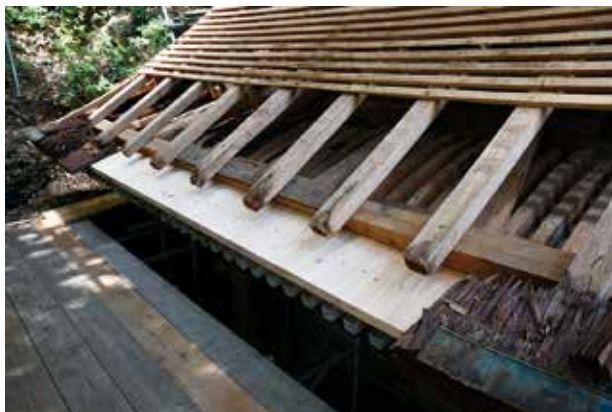
写真3 切裏甲取替状況
