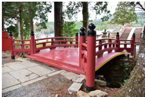
禊橋の竣工状況(神橋を望む)
