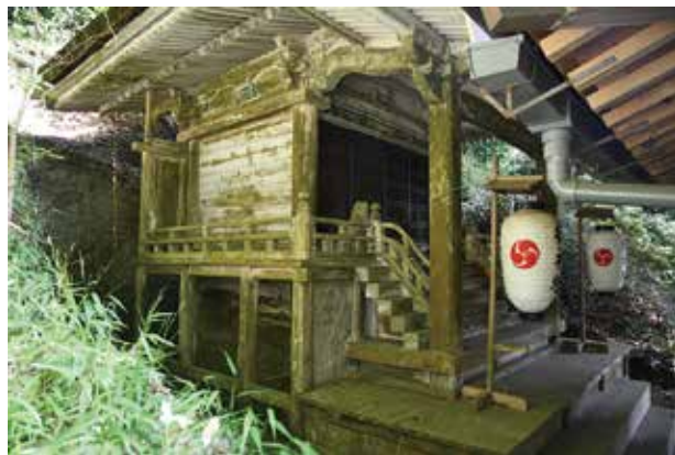
写真1 本殿の修理前全景（南西からみる）
