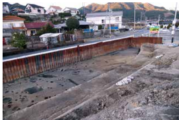
第3遺構面 完掘状況（南東から）
