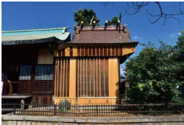
竣工（左に隣接するのは、登録有形文化財である幣殿）
