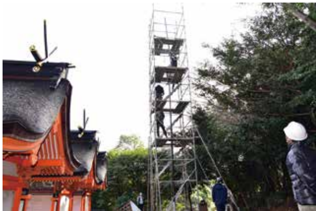
避雷針の組立状況
