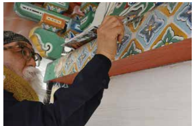
彩色の剥落止め作業
