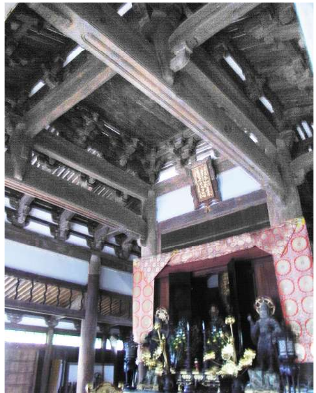
【禅宗様の外観と内部空間】方三間裳階付き仏殿 善福院釈迦堂（現存最古）
