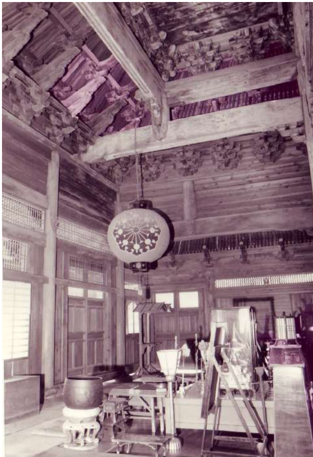
不動院金堂正面側見返し
