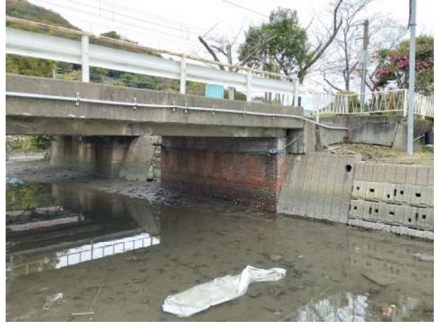
写真5 国体第1号橋台
