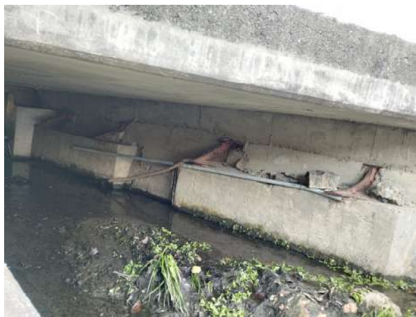
写真 12 和歌山バス株式会社付近橋梁 I形鋼
