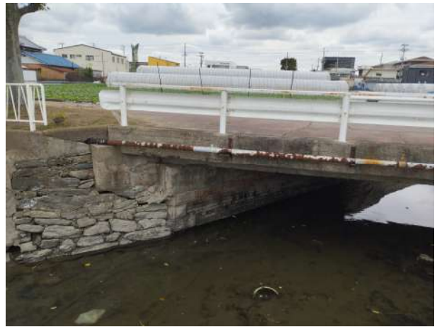
写真6 国体第2号橋台
