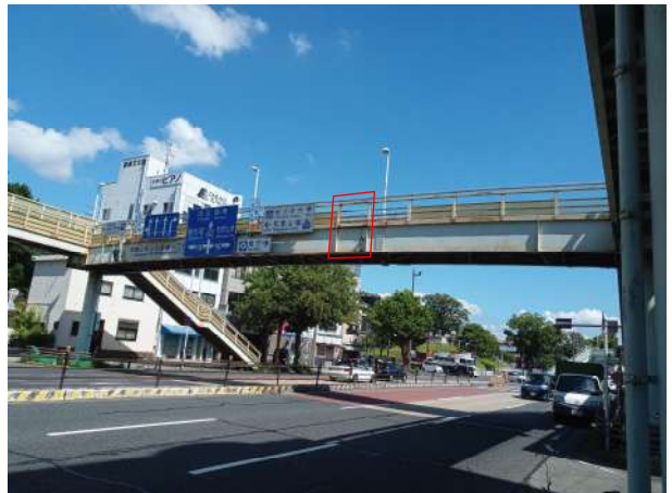
写真 8-2 県庁前横断歩道橋 全体
