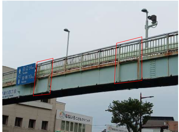
写真 9 日赤前横断歩道橋 階段痕跡
