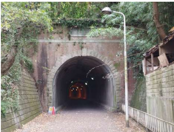
写真7-1 鵬雲洞(北側坑口)
