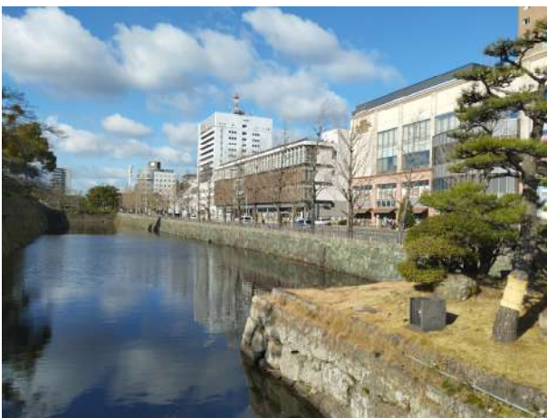
写真 10-1 堀側護岸 (奥の石積み)
