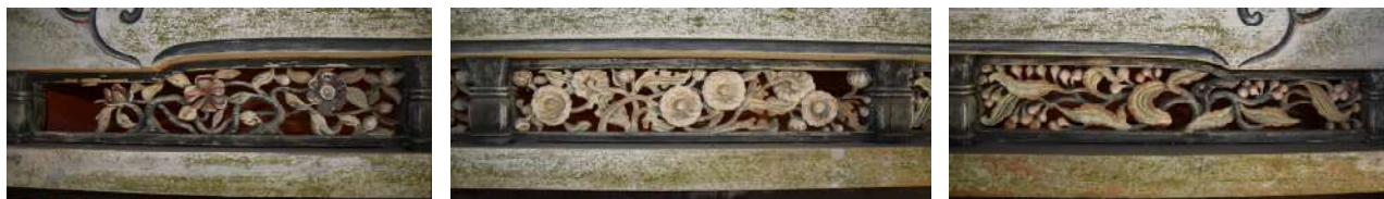
写真1 白岩丹生神社本殿の身舎正面上方
