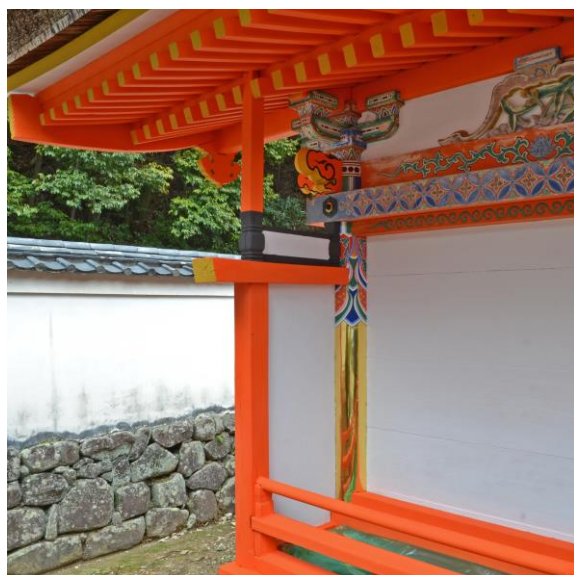
第一殿西側の脇障子 ↑ ↓ 第二殿東側の脇障子上方
