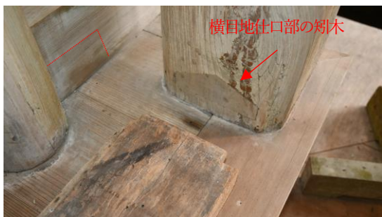
敷板の対応状況(東側)
