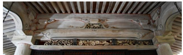
写真2 本殿の身舎正面上方
