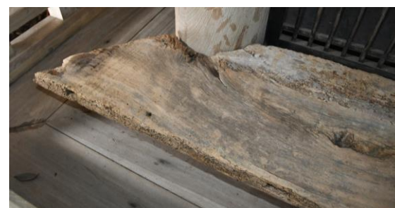
写真10 身舎柱との対応状況
