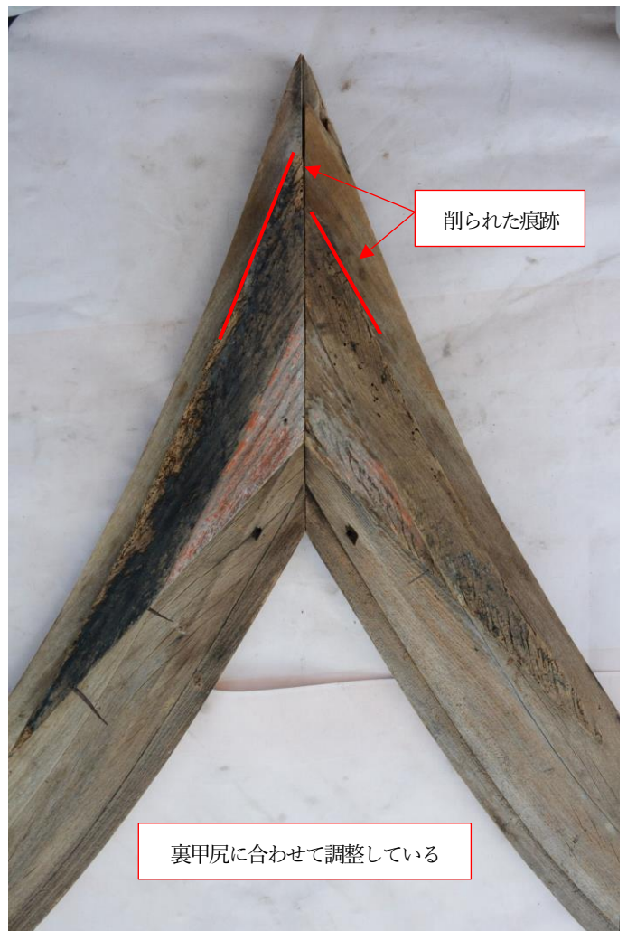
写真6 破風板と文化5年取替材の比較状況
