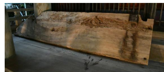
写真11 縁板の使用箇所確認状況
