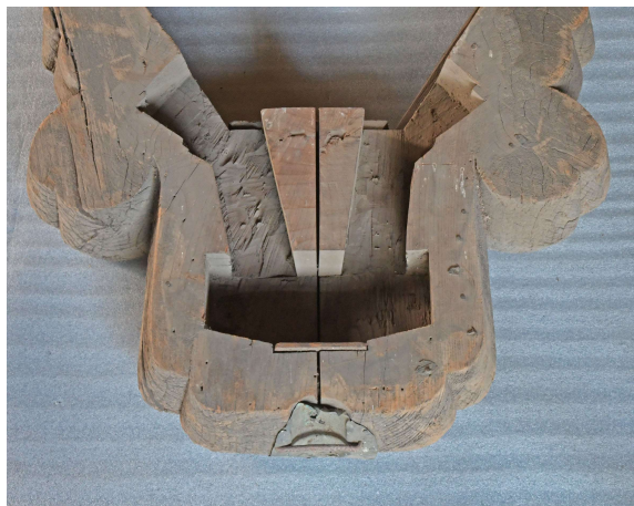
図8 八百萬殿、3代目鬼板(明治中期頃と推定) (頂部には鳥衾用の仕口が造られている)
