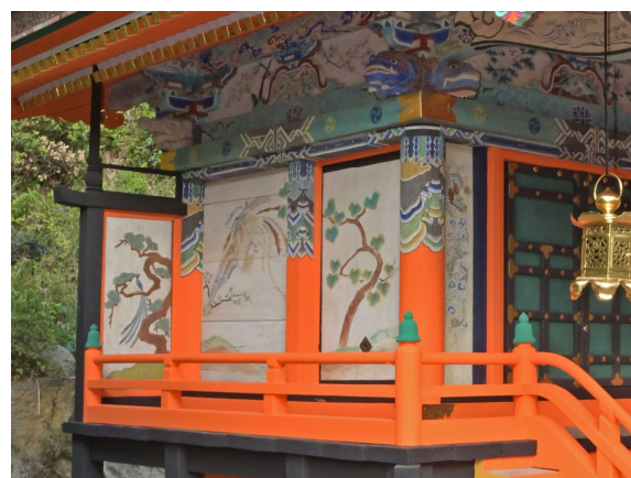
図6 須賀神社本殿（第二殿）の身舎軒下
