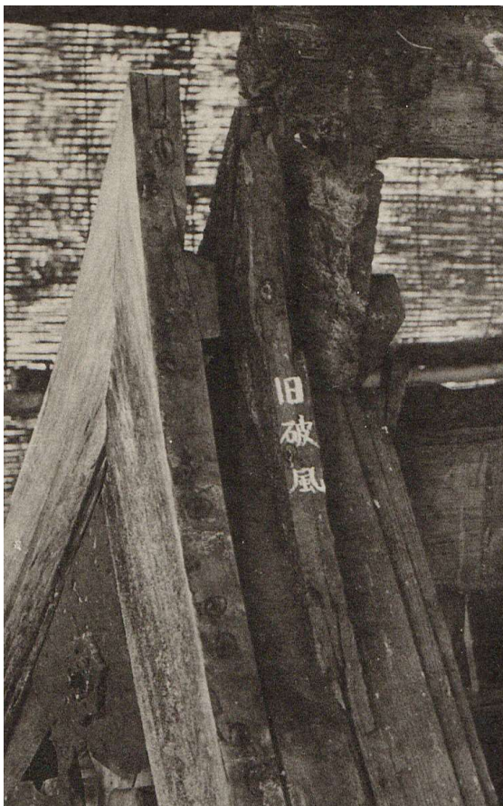
写真5 解体修理時の状況（S35）
