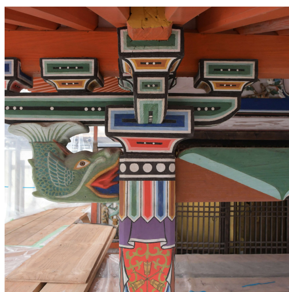
向拝西側の柱・頭貫・組物の納まり
