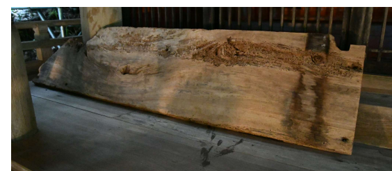
写真11 縁板の使用箇所確認状況
