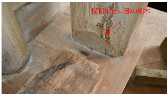
敷板の対応状況(東側)
