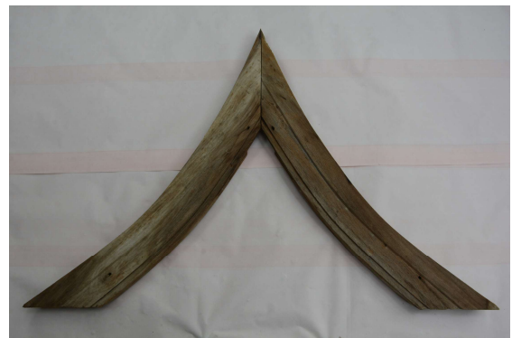
写真 15 正面千鳥破風の組付状況
