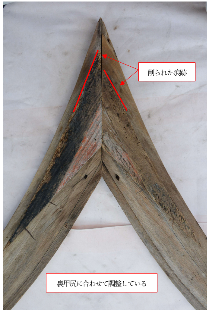
写真6 破風板と文化5年取替材の比較状況
