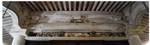
写真2 本殿の身舎正面上方
