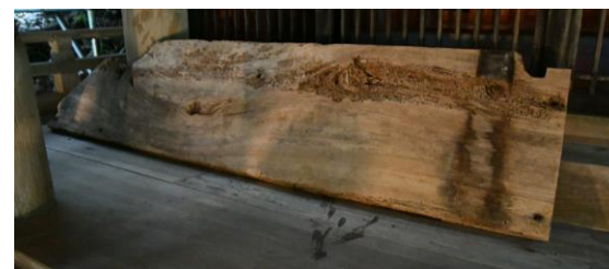
写真11 縁板の使用箇所確認状況
