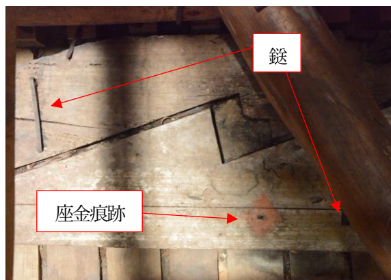
写真7 障泥破風板保管状況（向拝小屋内）
