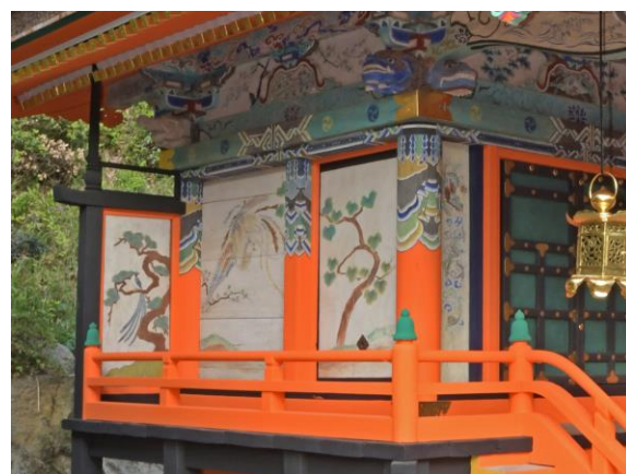
図6 須賀神社本殿（第二殿）の身舎軒下
