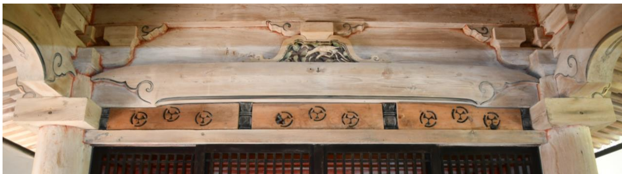
写真 26 身舎正面に欄間伏板を配した状況
