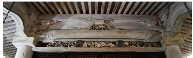
写真2 本殿の身舎正面上方
