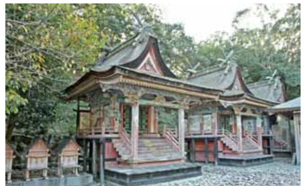
修理前の本殿全景（南西から見る、手前が第三殿）
