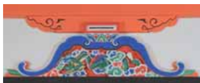
③塗装修理後の葺股
