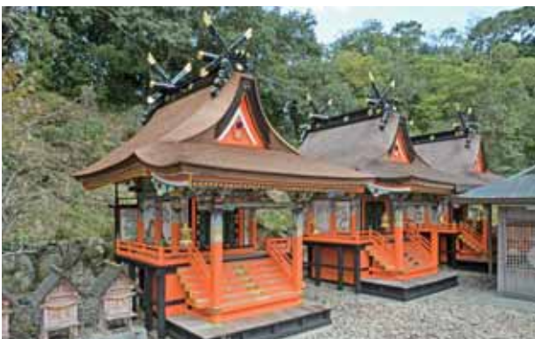
修理後の本殿全景（同右、棟まわりは黒色に整備）
