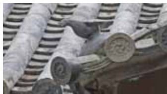
旧拝殿屋根の留め蓋瓦「鳩」
