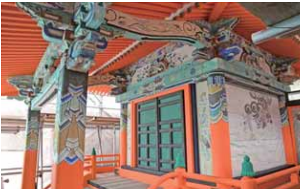
修理中の本殿（同右、彩色部補彩・単色塗り後）
