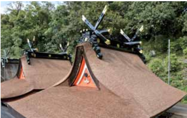
修理中の本殿屋根（同右、第三殿は未施工）
