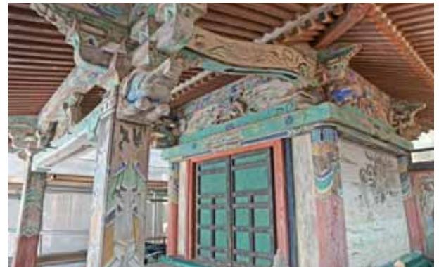
修理中の本殿（第二殿、彩色部剥落止め後）
