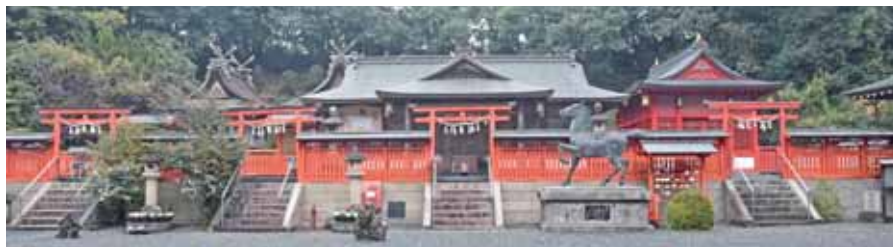
3. 旧拝殿から臨む本殿と拝殿(拝殿左奥に第二殿と第三殿が見える)
