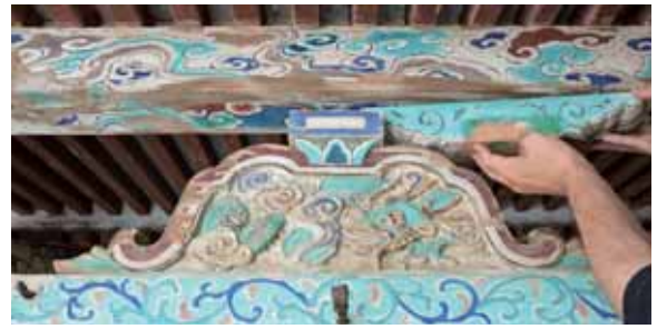
明治期の向拝桁彩色（第二殿、変色や剥落が進むなか、部材の裏側で施工当時の色味も判明した）
