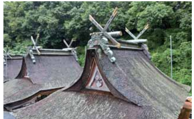
修理前の本殿屋根（南東から見る、手前が第一殿）
