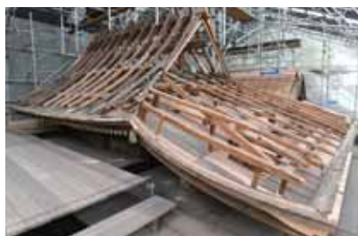
關雞神社本殿小屋組の修復
