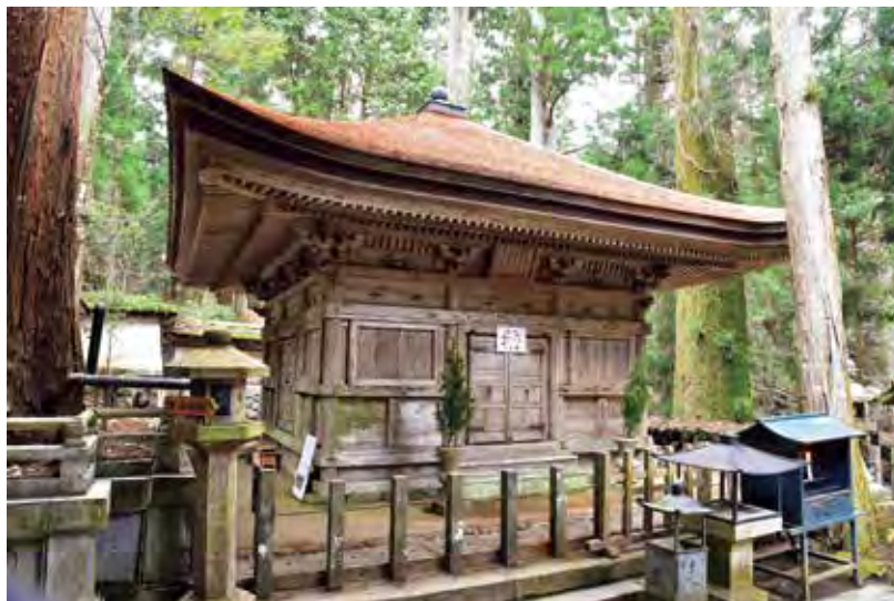
檜皮屋根の葺き替えが完成した奥院経蔵
