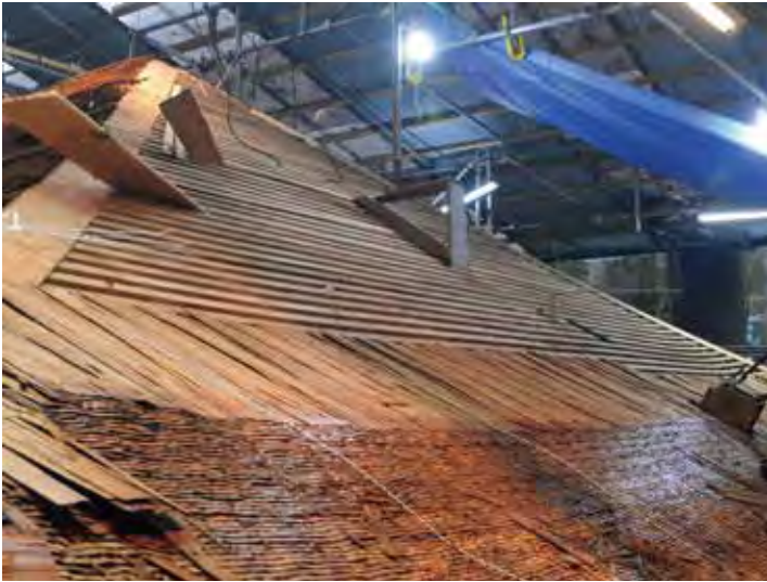
檜皮屋根葺き上げ状況（奥院経蔵）
