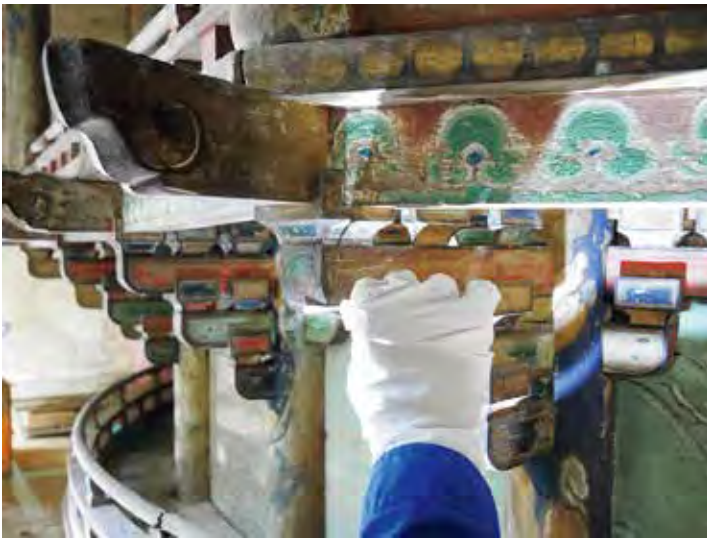
彩色のクリーニング施工状況
