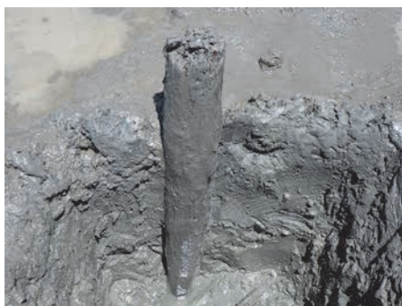
杭 断ち割り状況
