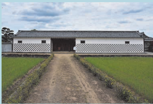
増田家住宅表門（岩出市曾屋） 竣工
