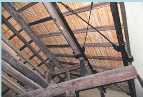
野地面に沿わせた耐震補強材
