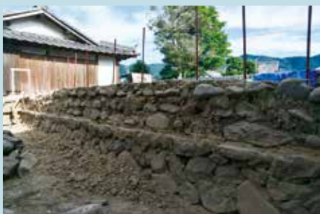
写真3 土塀表面の壁土を清掃した状況
