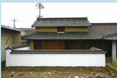
写真5 主屋前土塀の竣工状況
