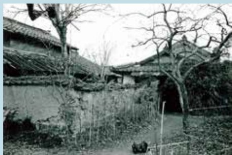
写真1 解体前の土塀 （主屋・離れを西からみる）
