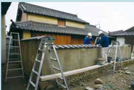
写真4 瓦葺き作業の状況
