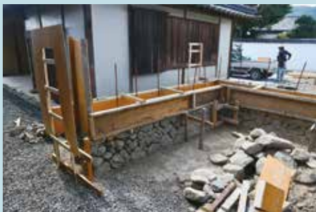
写真2 土塀東側入口の復旧状況
