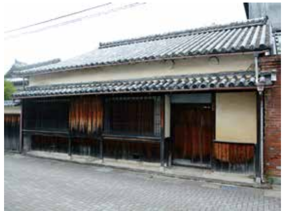
写真2 主屋（東より見る）
