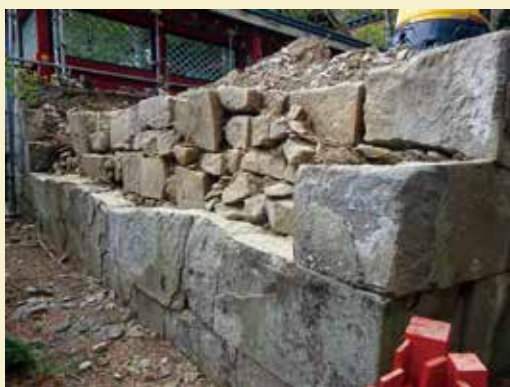
石垣3段目解体後 正面（南東から）
