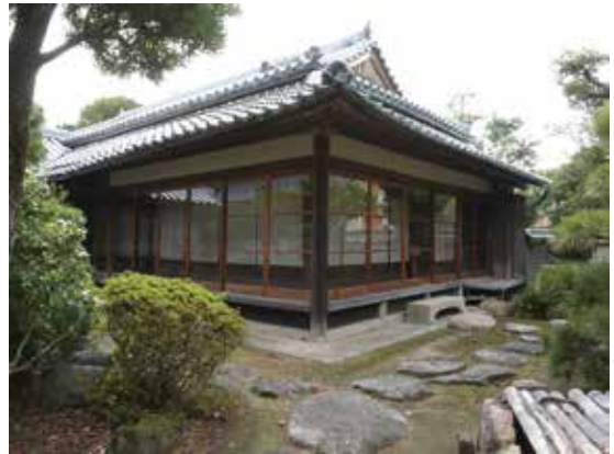
写真3 本座敷（北西より見る）
