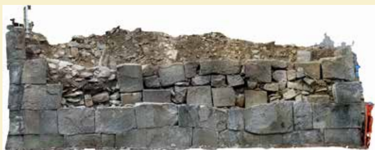
石垣3段目解体後 正面
