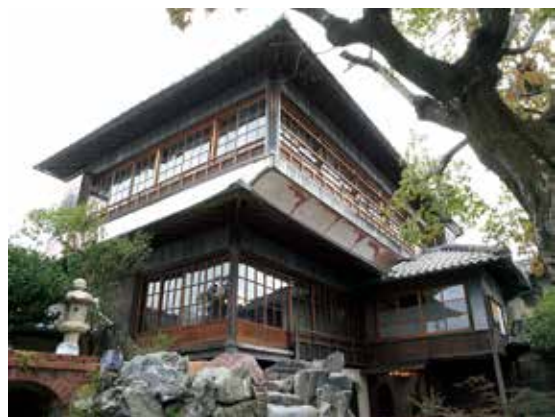
写真4 御風楼（南西より見る）
