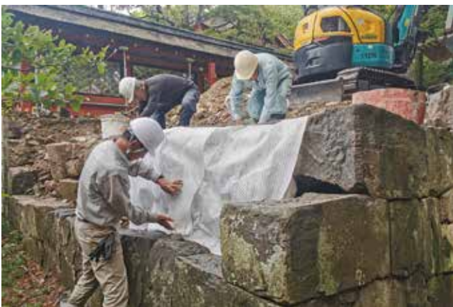
石垣の積み直し状況
