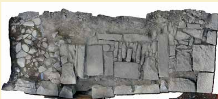
石垣1段目解体後 上面
