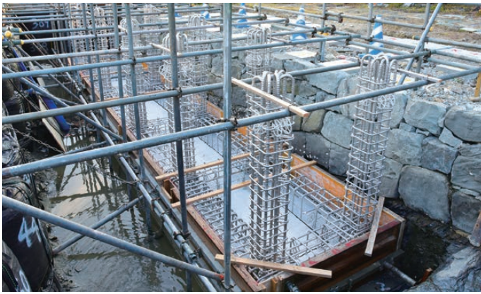
ステンレスを用いた海部配筋
