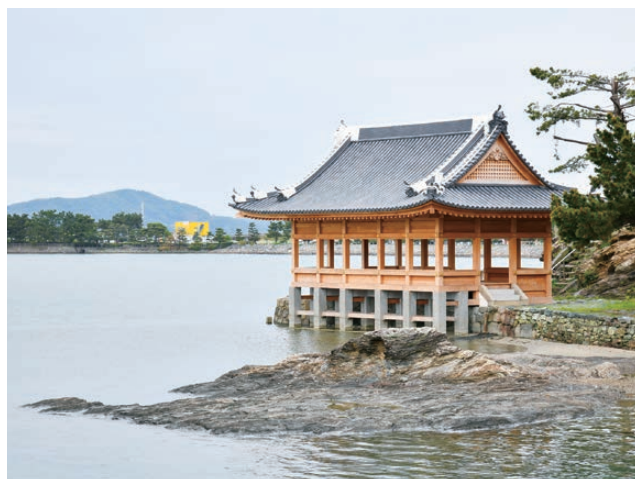
伝統的な技法で竣工した四代目観海閣
