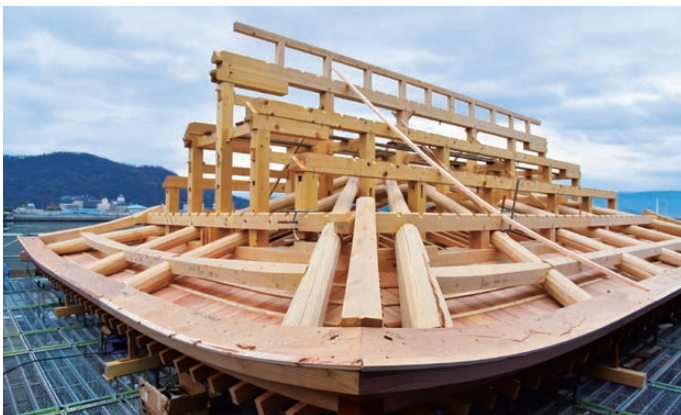
露天での伝統工法による小屋組の組立
