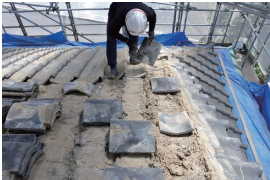
写真2 瓦の解体状況（御風楼3階南面） 瓦をめくりながら金槌でたたき、瓦が割れているか確認をしています。割れていない瓦は高い音、割れている瓦は低く鈍い音がなります。
