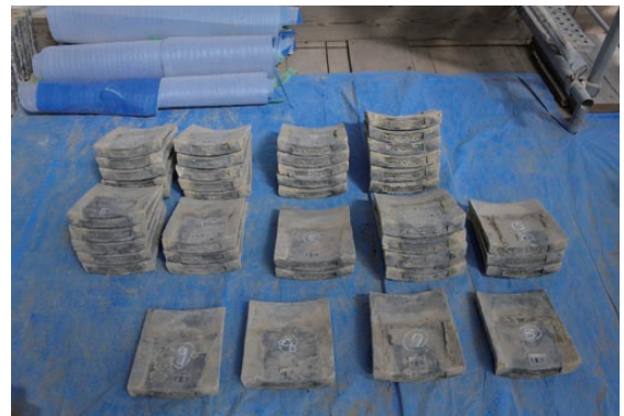
写真5 主屋 軒平瓦の分類状況
