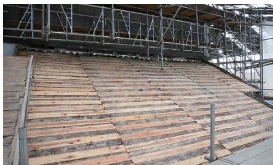
写真12 御風楼1階東面 野地の状況
