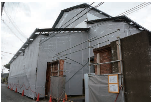
写真1 素屋根の組立が完了した状況 (北東より見る)
