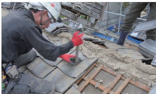
写真7 本座敷本屋根 瓦の解体状況（南面）
