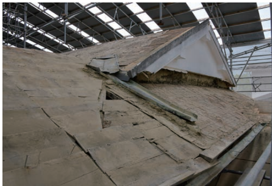
写真6 主屋 野地の状況（南面西側）
