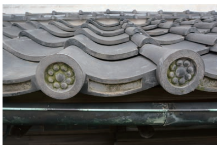
写真10 丸棧瓦（御風楼2階北面庇）
