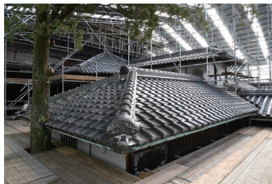
写真13 渡廊下・南角屋の屋根面（解体前） （南西より見る）
