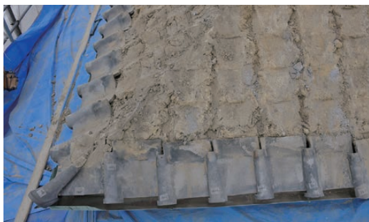
写真11 瓦の解体状況（御風楼3階南西隅）
