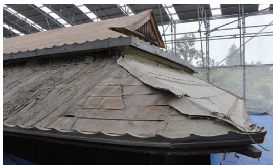
写真8 本座敷北西縁庇 葺土解体後の状況（北西より見る）
