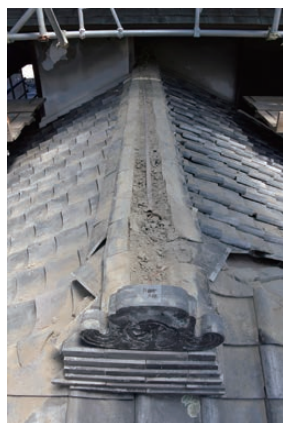
写真16 西角屋大棟の解体状況 （西より見る）
