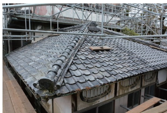
写真15 西角屋の屋根面（解体前）（北西より見る）
