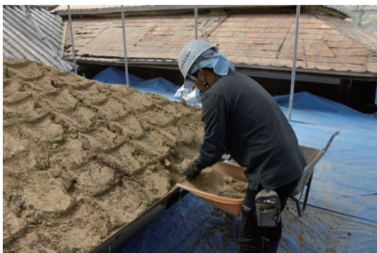
写真3 葺土の解体状況（御風楼南角屋西面）
