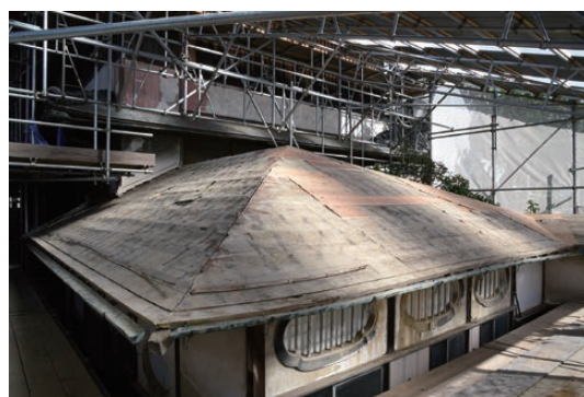
写真17 西角屋野地の状況 （北西より見る）
