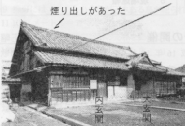
■ 旧中筋家主屋 土間側より見る
