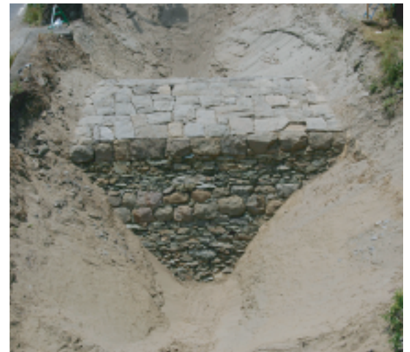
石積み堤防 東側（陸側） 東から
