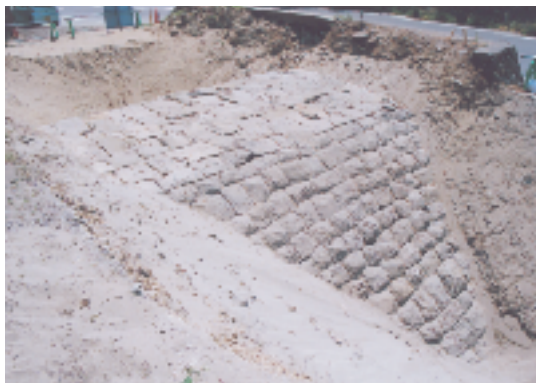
石積み堤防 西側(海側) 北西から
