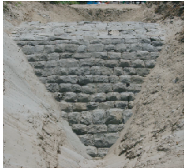
石積み堤防 西側（海側） 西から
