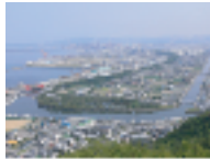
水軒堤防遠景（南から）
