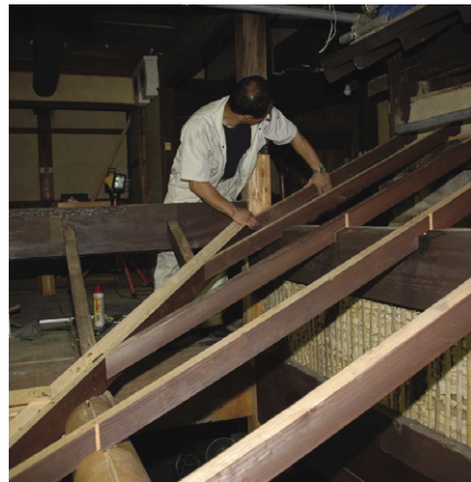
主屋中庭部分の垂木を取り付ける赤根棟梁
