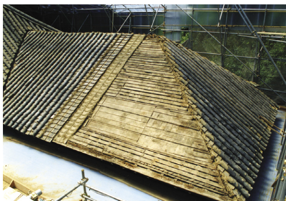
写真1 解体中の求聞持堂の屋根の状況
