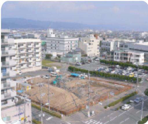
発掘調査現場 遠景
