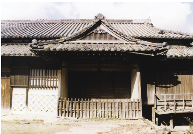
旧中筋家住宅主屋の式台玄関(修理前)
