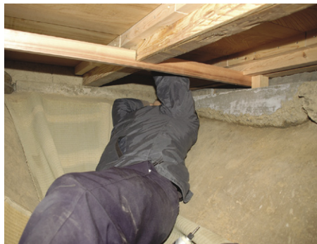
床下の穴に入って床板裏面の調整作業
