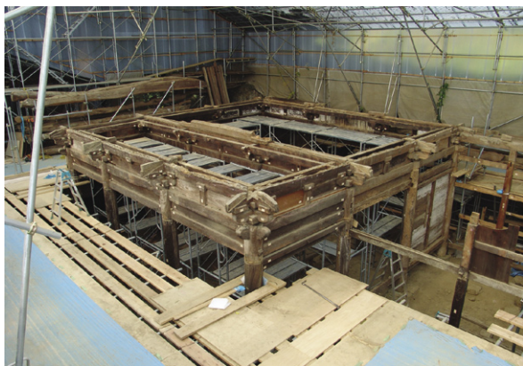
修理のため解体作業中の本堂
