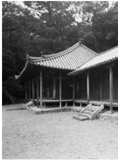
修理前(現状)の外観
