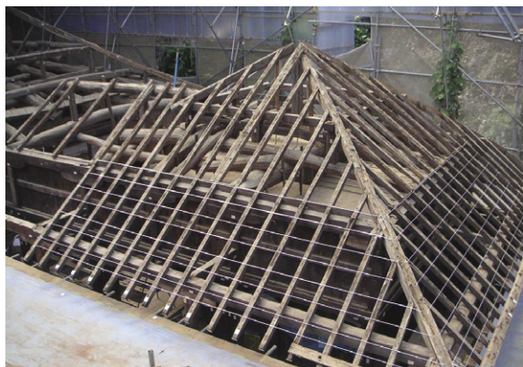
後世の改造部分を取り除いた求聞持堂の屋根
