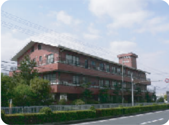
調査事務所が入っている建物外観
