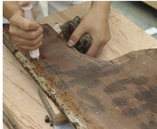
▲ 松材の丸桁の矧ぎ木修理
