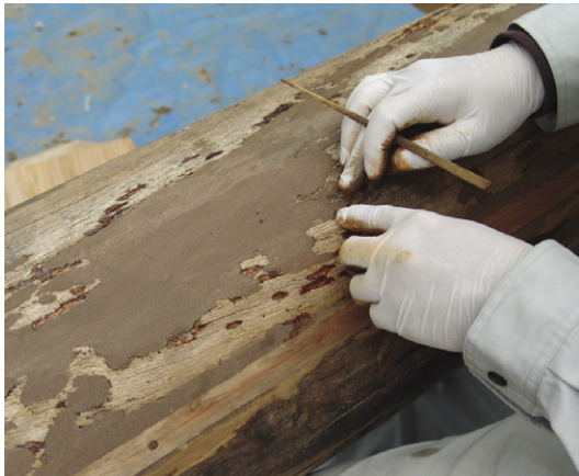
▲ 頭貫の継ぎ木補修(桐材)
