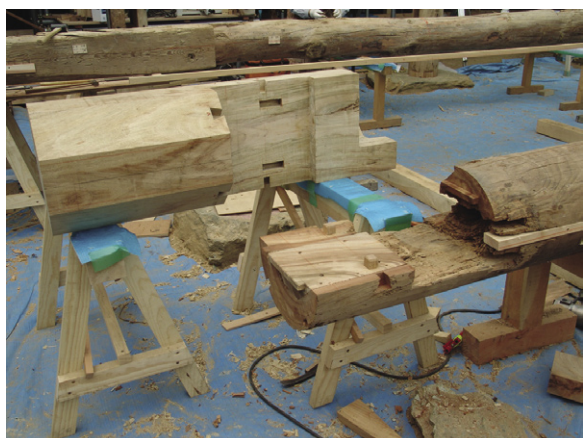
腐朽した柱の根継(補材)
