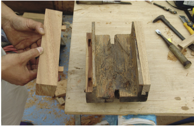
軒を支える組物の補修(楠材)
