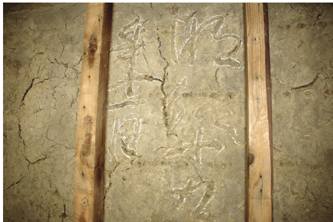
置屋根下の土屋根面には明治十九年十一月のへら書きがあった
