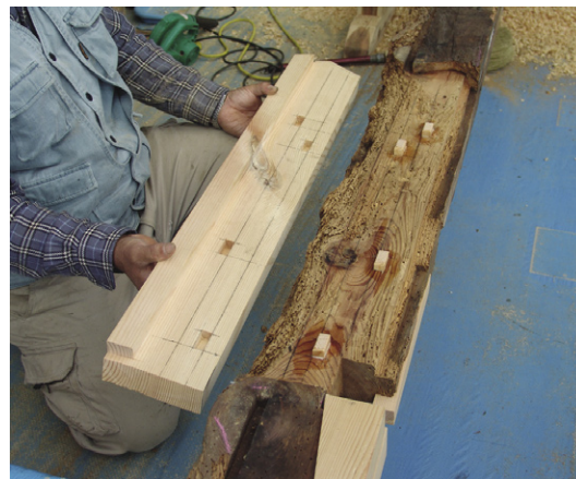
▲ 松材の丸桁の矧ぎ木修理
