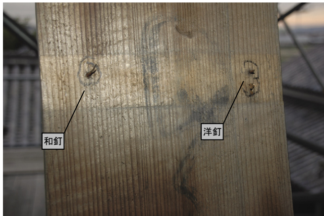
置屋根野地板は洋釘と和釘を併用して張られていた
