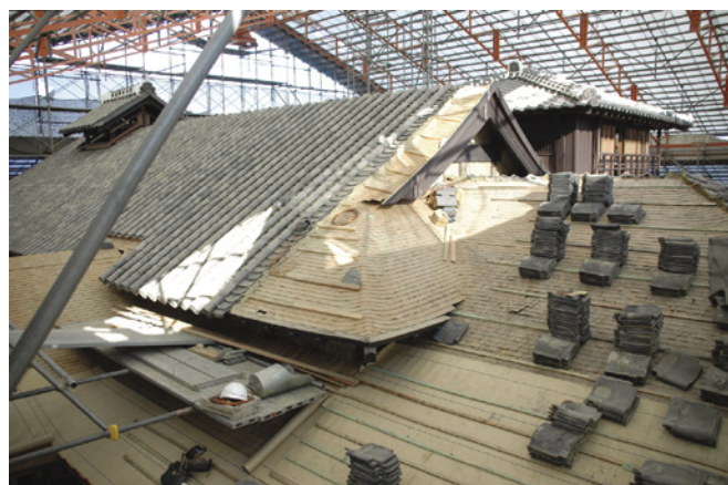
左側は土間台所屋根の本瓦葺
