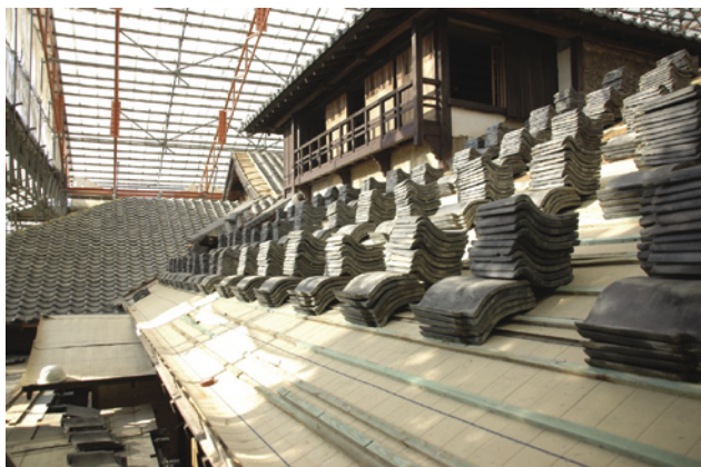
屋根葺き中の旧中筋家住宅主屋
