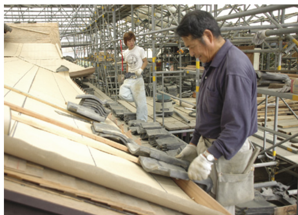
軒瓦を仮並べする
