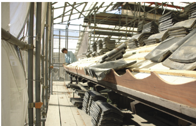
▼ 軒先には瓦縁りの板を打つ
