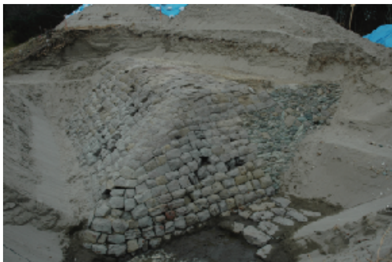
写真6 水軒堤防石堤南端部(南西から)
