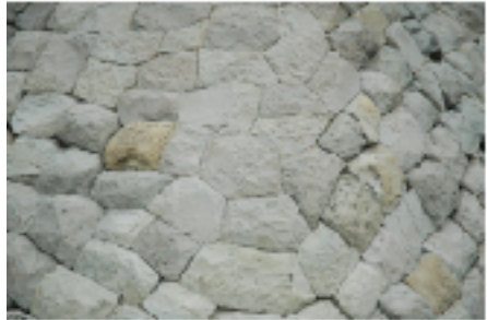
写真2 精緻な切り込みはぎ部
