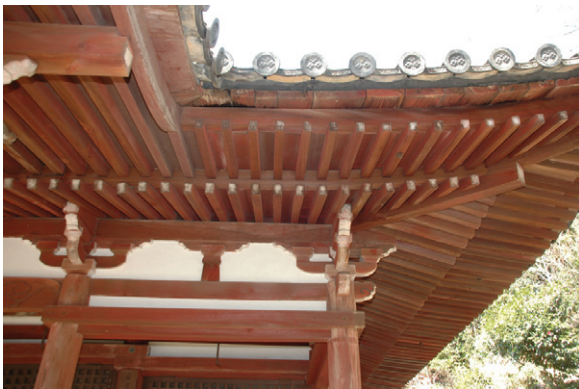
開山堂の軒見上げ 文化財未指定の開山堂（江戸前期）には、指定3棟が昭和修理で失った軒裏を一面に弁柄で塗る仕様が、今も残されている。
