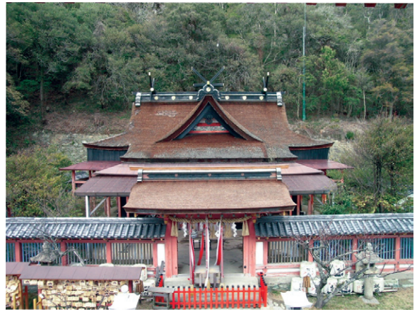
天満神社本殿を正面から見る
