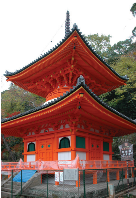
竣工なった多宝塔
