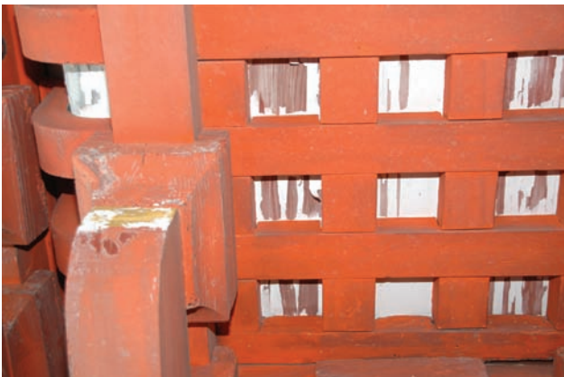
楼門修理前 白い胡粉塗りの下に元の赤い弁柄が見える
