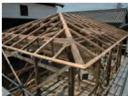
組み上げ中の茶室
