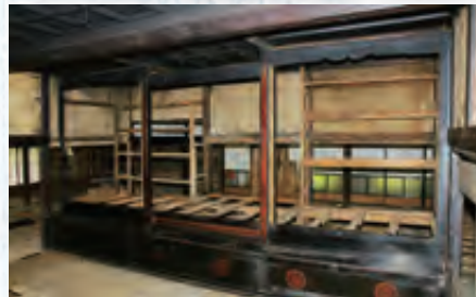
客殿「持仏の間」の解体状況
