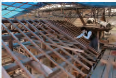
組み上げ中の人力車庫
