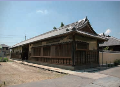
仮設屋根を撤去した表門
