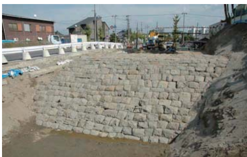
石垣西側全景（西から）
