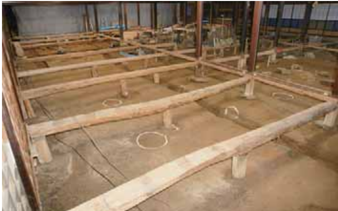
写真1 大広間床下の前身建物遺構
