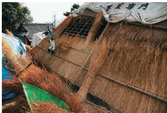
茅葺き屋根葺き替え作業の様子
