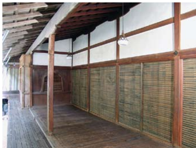
写真1：客殿西面の修理状況 (「広縁」奥が「上々段」。外周柱筋での中古建具の組立前の状況は、当初形式に近い姿を示している。)
