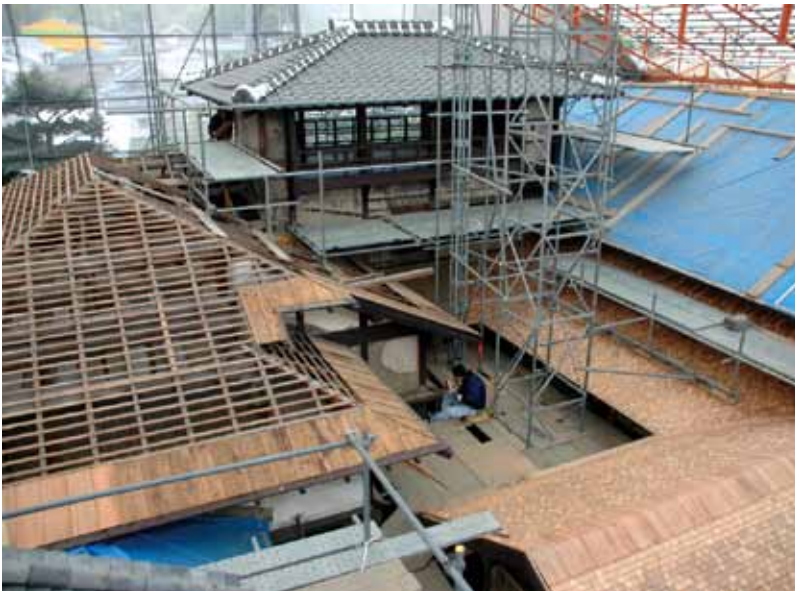
半解体修理中の主屋 中央に三階望楼が見える
