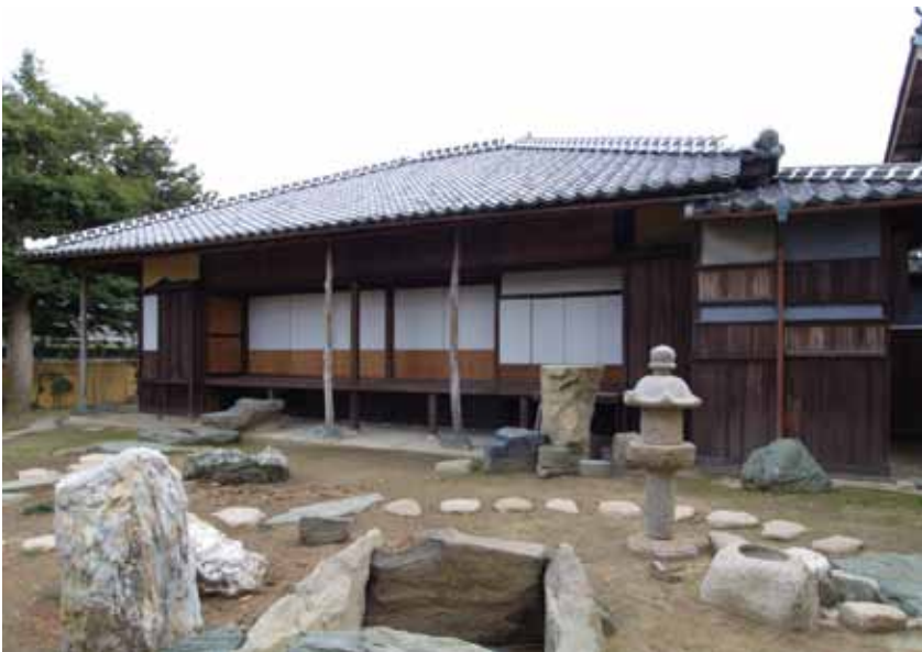
主屋大広間を北側から見る 北側には庭園が広がっている
