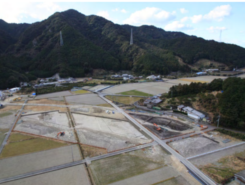
調査区近景（北東から）
