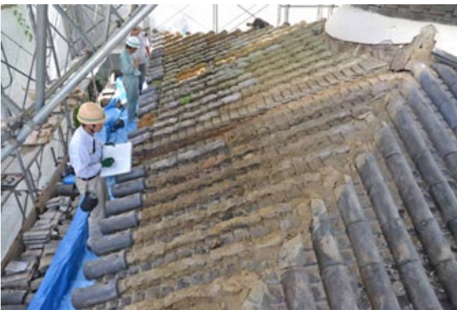
多宝塔屋根瓦の解体状況
