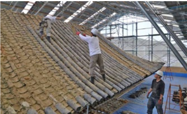
大門屋根瓦の解体状況
