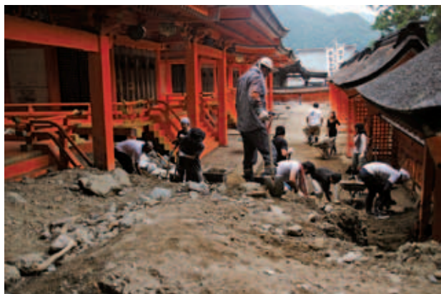
神社関係者の手作業による土砂撤去作業
