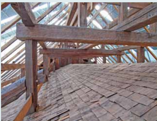
写真2 第一殿・第二殿の小屋組状況
