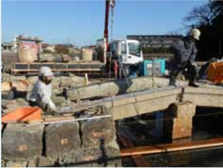
写真2 東橋の橋桁組立状況
