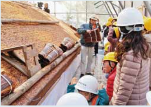
修理現場公開時の様子
