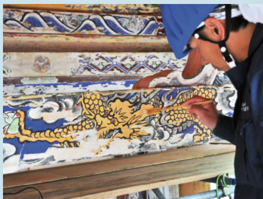
剥落止めの施工中
