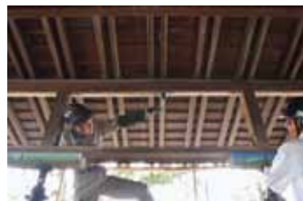
写真11. 軒桁の吊り込み状況
