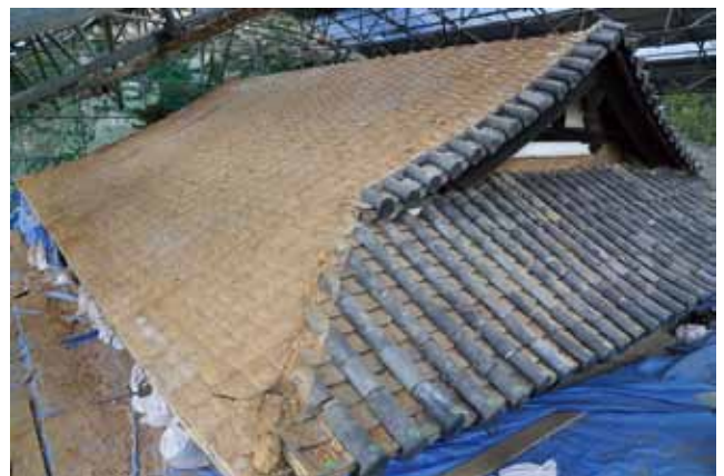
写真5. 浜座敷屋根瓦の分解状況（南東）
