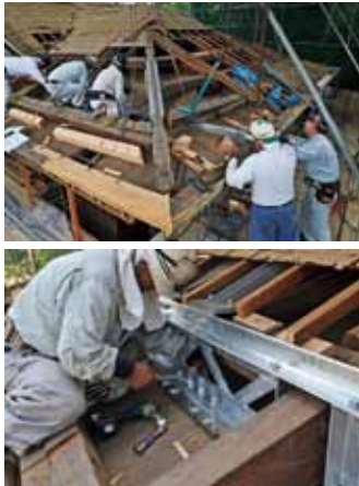
写真10. 鉄骨梁の組立状況
