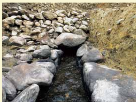
写真2 蓋石をはずした状況（南から） 水の流れと充填されていた河原石の状況
