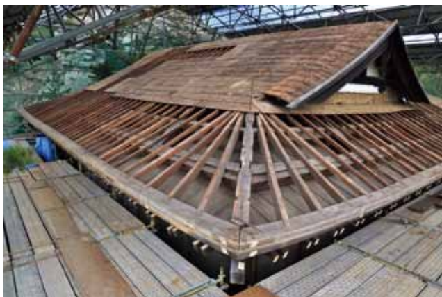
写真6. 浜座敷屋根野地の分解状況（南東）
