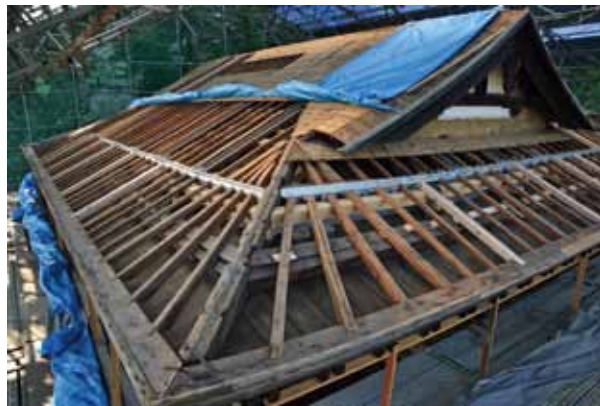
写真9. 浜座敷野地の組立状況（南東）
