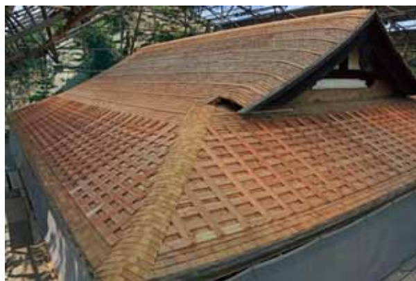
写真12. 浜座敷屋根下地の施工状況（南東）
