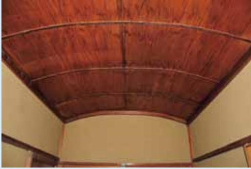
温山莊園茶室 廊下の天井。 天井板が無垢材では表現できない曲面に張られている。
