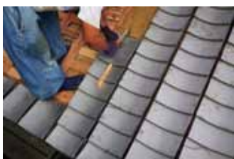
写真13. 屋根瓦葺きの状況
