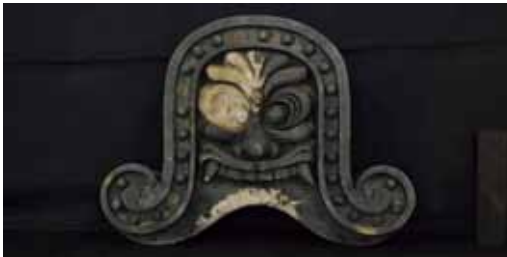
写真 7. 浜座敷の軒先瓦（上）と大棟鬼瓦（下）
