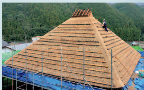
葺き替えが完成間近の屋根
