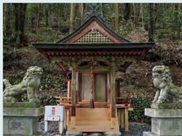
写真2 木工事完了時の社殿
