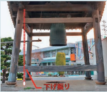
下げ振りで柱の傾斜を見る
