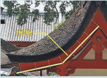
水糸を設置して実測
