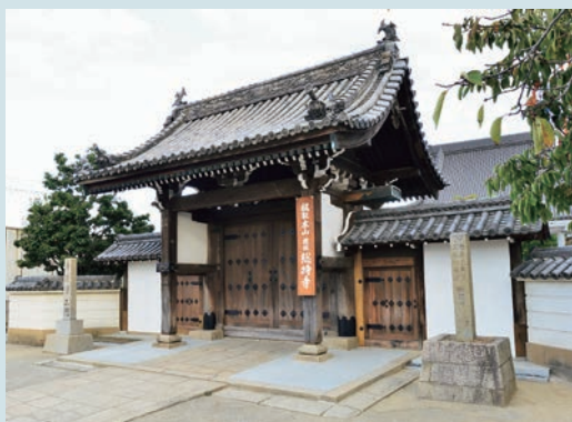
写真2 竣工した総門
