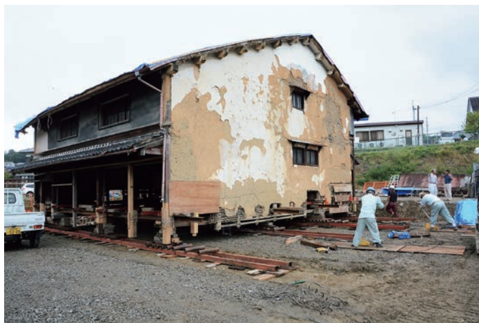
写真6 主屋曳家工事
