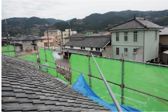
写真5 みそや別館 主屋屋根工事用足場より火伏医院を臨む
