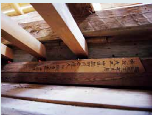
写真2 小屋組内の墨書
