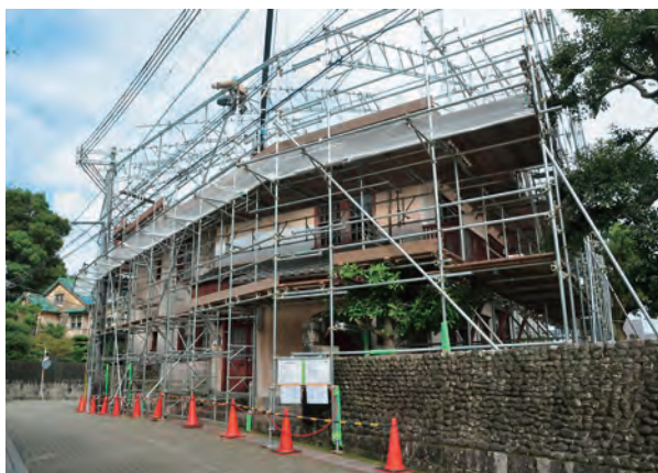
写真3. 伊佐田通りより建設中の素屋根を見る
