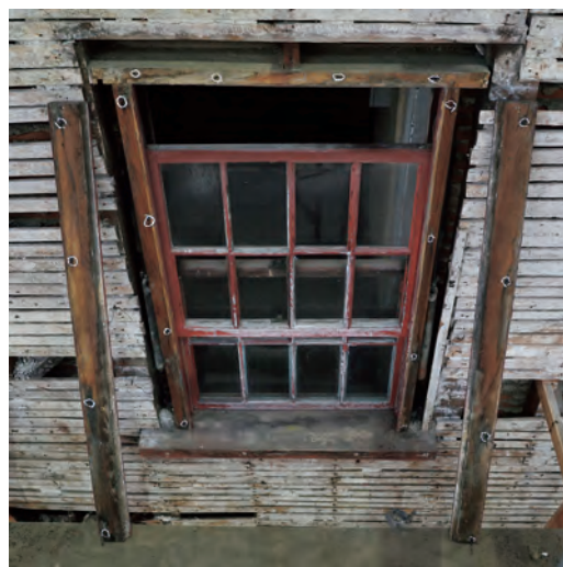
写真6. 分解中の上げ下げ式ガラス窓
