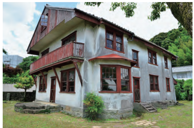
写真1. 主屋の外観を南東より見る
