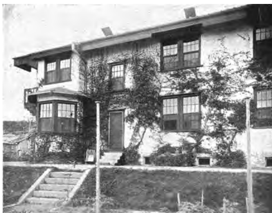
写真9. 大正8年（1919）頃の東面外観
