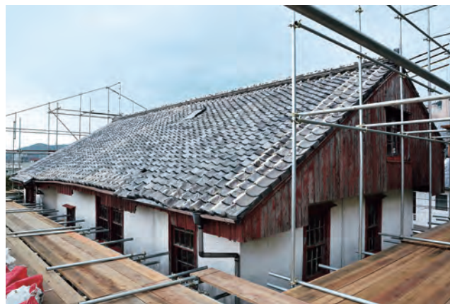
写真4. 瓦屋根を北東より見る
