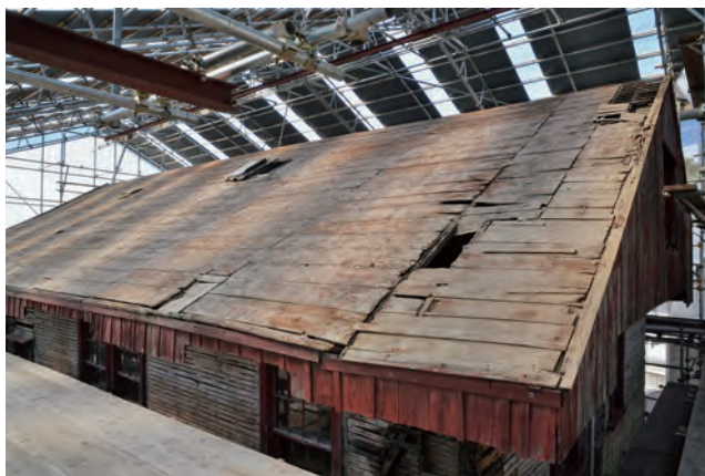
写真5. 屋根下地を北東より見る
