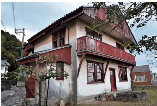
写真2. 主屋の外観を南西より見る
