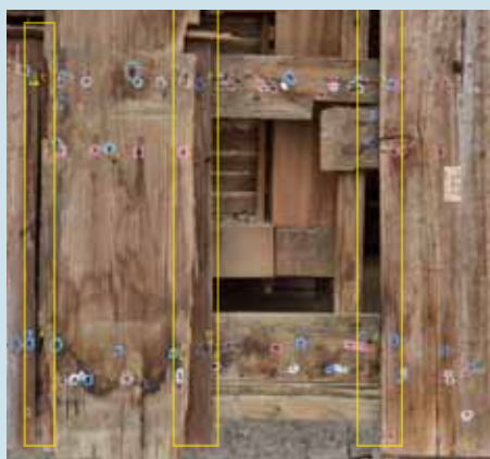
下層の壁板(上記写真枠部分、線は目板位置) チョーク色部分 (黄:目板、青:付け替えた釘痕、赤:当初の釘痕)
